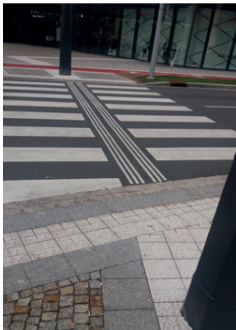
Obr. 13 vodicí pás přechodu
