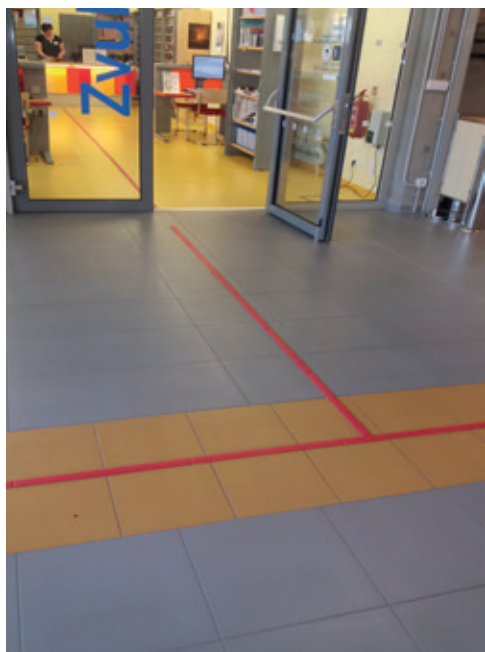
Obr. 05: umělé vodící linie v interiéru
