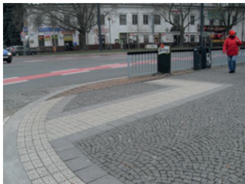
Obr. 06 možné řešení signálního pásu u přechodu
