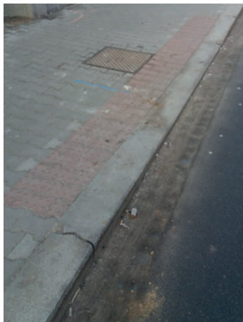
Obr. 09 varovný pás v místě sníženého obrubníku
