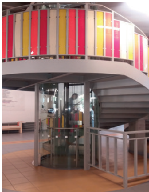
Obr. 30 správné zabezpečení schodiště v prostoru
