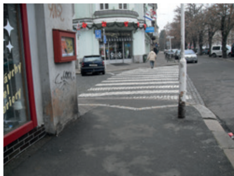
Obr. 10 Chybné řešení – absence varovného i signálního pásu u přechodu
