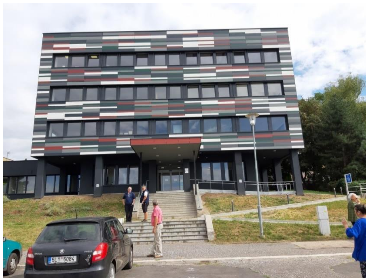
Nová budova Jičín
